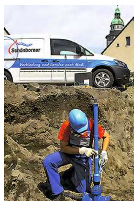
Verbindungen nach Maß: auf einer Baustelle in der August-Bebel-Straße in Finsterwalde montiert ein Mitarbeiter des Unternehmens die Schönborner Armaturen.
