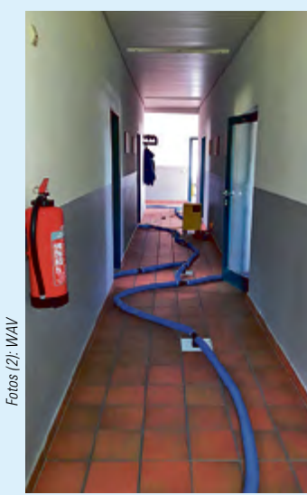
Spezialtechnik trocknet den Fußboden in der Umkleide und auf dem Flur.
