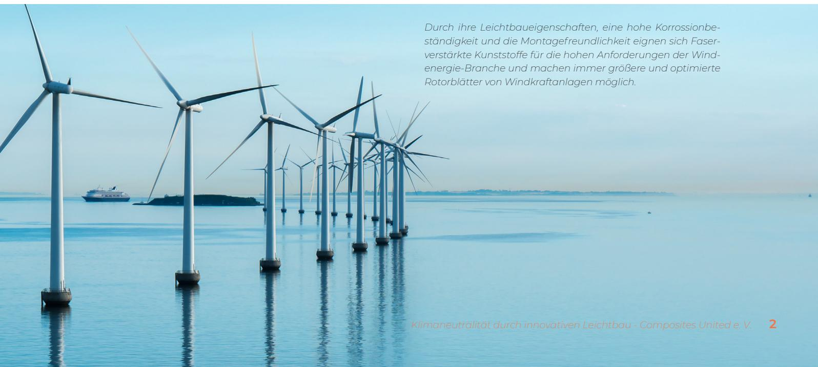
*Durch ihre Leichtbaueigenschaften, eine hohe Korrosionsbeständigkeit und die Montagefreundlichkeit eignen sich Faserverstärkte Kunststoffe für die hohen Anforderungen der Windenergie-Branche und machen immer größere und optimierte Rotorblätter von Windkraftanlagen möglich.*
