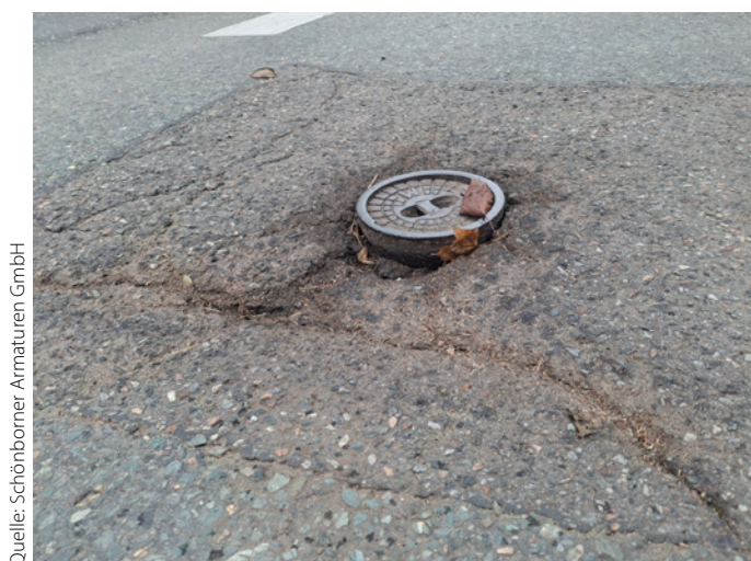
Bild 1: Überfahrten durch schwere Nutzfahrzeuge führen häufig zu Setzungen im Umfeld der Straßenkappen. Die Folgen unter anderem Schlaglöcher, die z. B. die Lebensdauer der Infrastruktur beeinträchtigen können.
